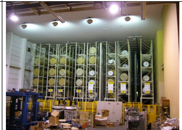
No.10 製品倉庫C棟内部 自動倉庫
