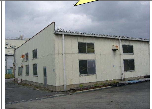
No.9 製品倉庫B棟
