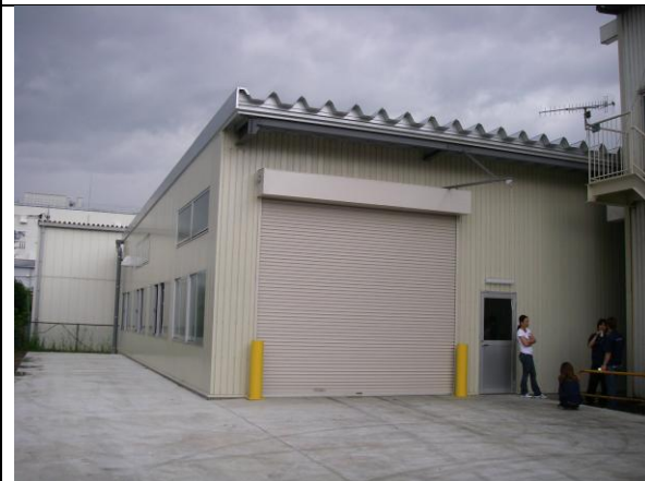
No.10 製品倉庫C棟
