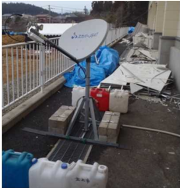
衛星固定局の設置（陸前高田市）
