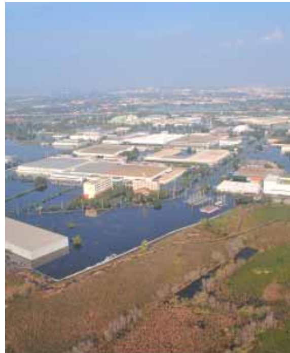
写真 1 バンカディ工業団地の浸水状況 （パトゥムタニ県）（10月23日時点）
