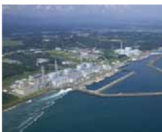
図 1.1 福島第一原子力発電所全景
